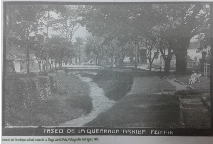
Melitón Rodríguez, Puente del Arzobispo, actual cruce de la Playa con el Palo, 1910.
